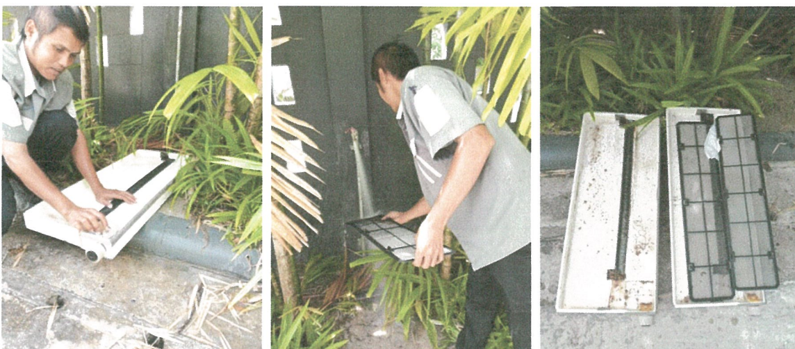
รูปภาพที่ 2.43 การทำความสะอาดเครื่องปรับอากาศ/ถาดรองรับน้ำ และอุปกรณ์ระบายอากาศ
