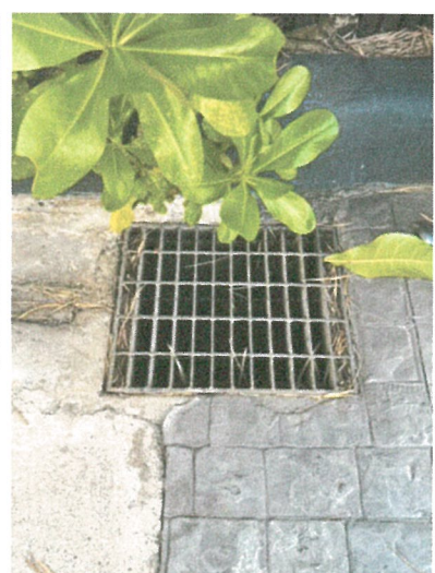
รูปภาพที่ 2.3 บ่อพักน้ำและตะแกรงดักมูลฝอย
